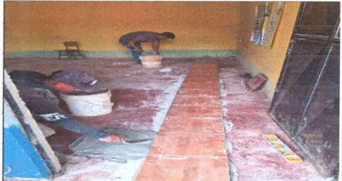
Foto 2: Colocación de piso ceramico en dos aulas, bodega y pasillo del modulo numero uno de la escuela.
