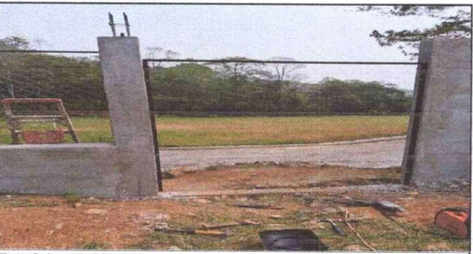
Foto 5: Instalación de porton en la primera entrada del muro perimetral.
