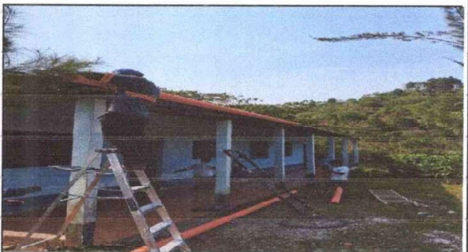
Foto 4: Instalación de canales de tubos PVC con conexión a pila de agua.
